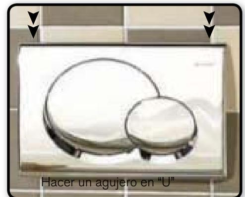
**7.** Cortar una "U" en el lado superior derecho o izquierdo de la placa para encajar la canaleta o el tubo flexible de 3mm dependiendo del modelo o de la instalación.
